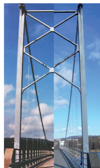
Most Kalvoya v Norsku byl ošetřen ZINGA® v roce 1985. Po více než 30 letech je most stále v dobrém stavu.
